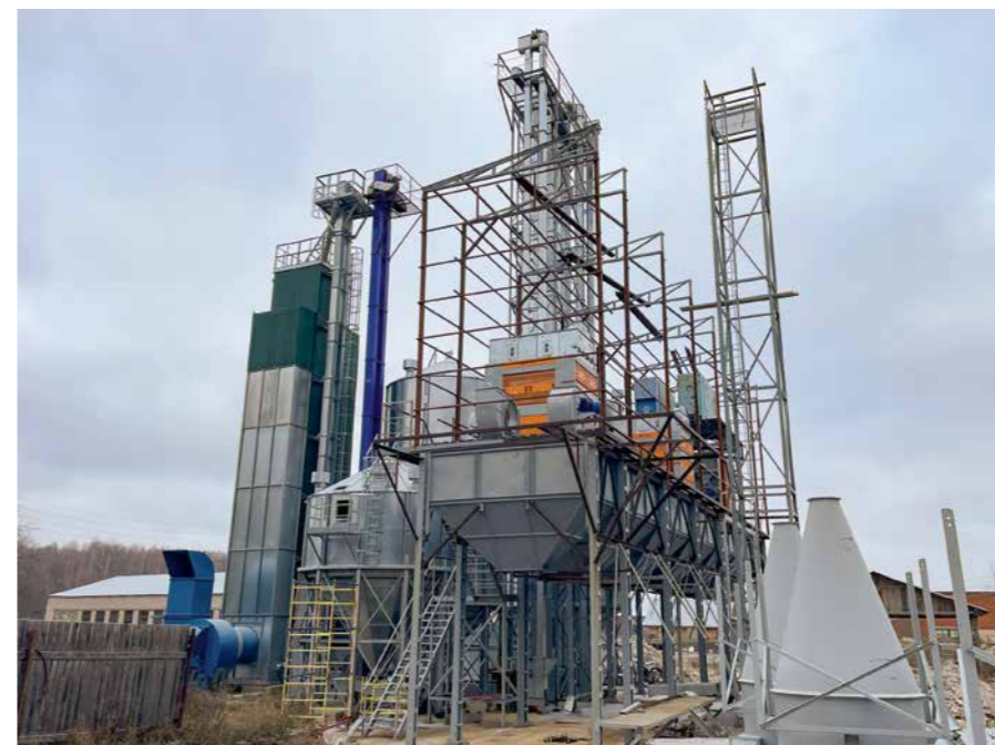
В «Агрохолдинге» строят зерносушильный комплекс «Амкодор»
