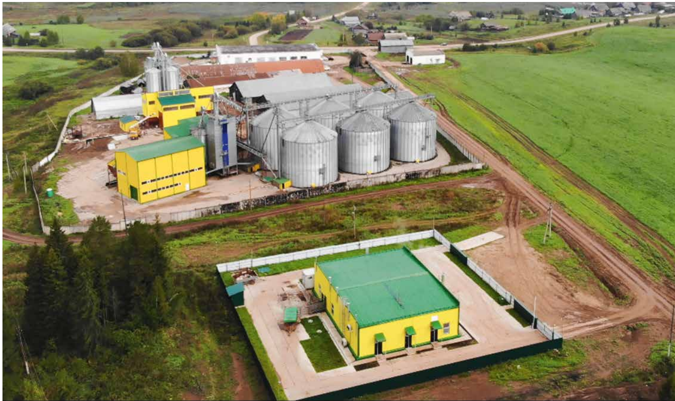
В 2019 году в хозяйстве построили комплекс с мощностью сушильных установок 140 тонн зерна в час
