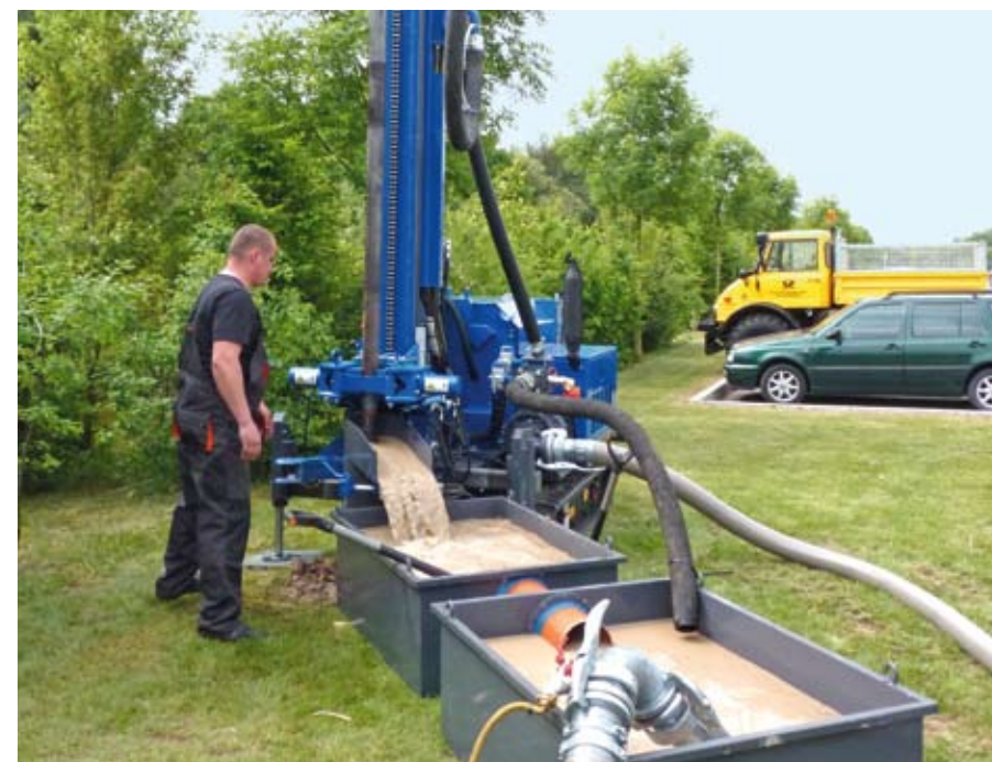
Самоходная буровая установка Rotomax компактна, на резиновых гусеницах, не оставляет серьезных следов на участке
