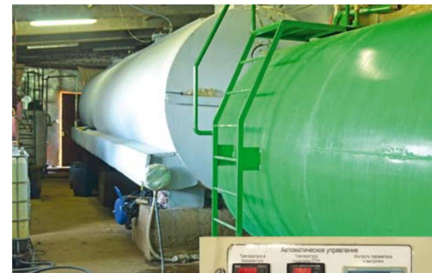
Истобенский биореактор объемом 25 кубометров перерабатывает 3 тонны навоза в день
