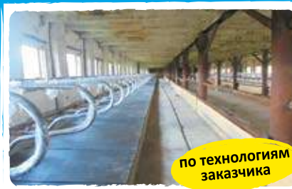
Строительство и ремонт ферм и производств. помещений
